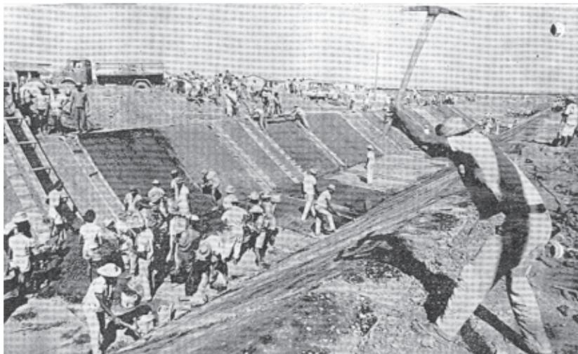
Foto 1: Construção do canal de irrigação principal.
